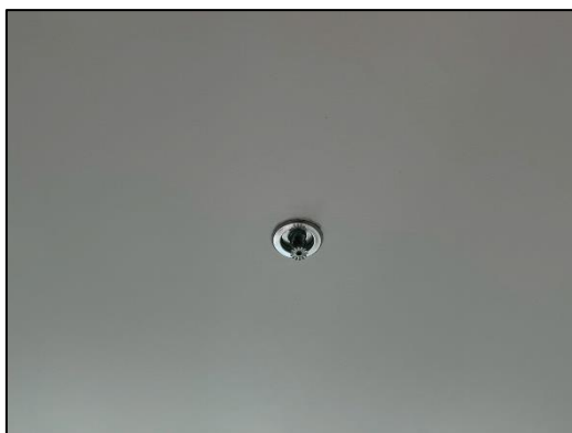
ภาพที่ 2-40 หัวกระจายน้ำอัตโนมัติ
