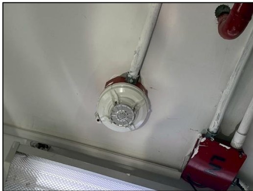
ภาพที่ 2-35 เครื่องตรวจจับควัน
