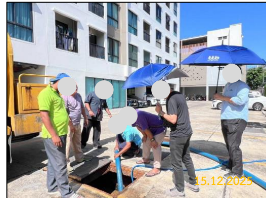
ภาพที่ 2-11 สุ่มกากตะกอนส่วนเกินจากระบบบำบัดน้ำเสีย
