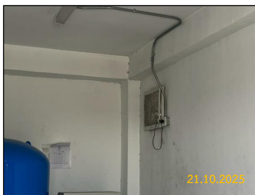
ภาพที่ 2-45 พัดลมระบายอากาศ
