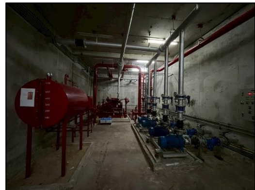
ภาพที่ 2-37 เครื่องสูบน้ำแบบเครื่องยนต์และเครื่องสูบน้ำดับเพลิง
