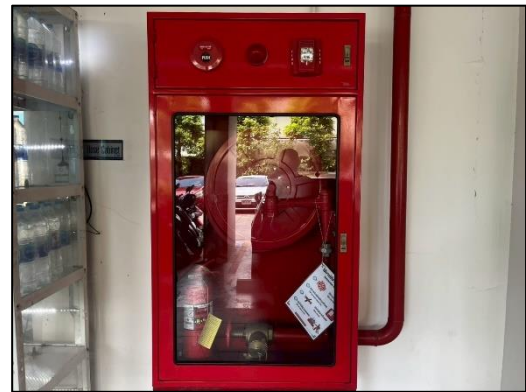
ภาพที่ 2-39 ตู้ดับเพลิง (FHC)
