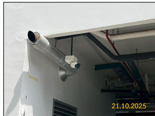
ภาพที่ 2-55 ระบบกล้องโทรทัศน์วงจรปิด (CCTV)
