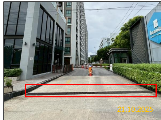
ภาพที่ 2-16 ตะแกรงครอบรางระบายน้ำ
