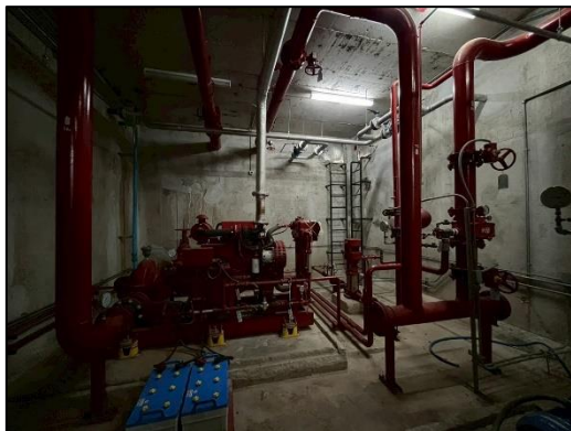
ภาพที่ 2-37 เครื่องสูบน้ำแบบเครื่องยนต์และเครื่องสูบน้ำดับเพลิง
