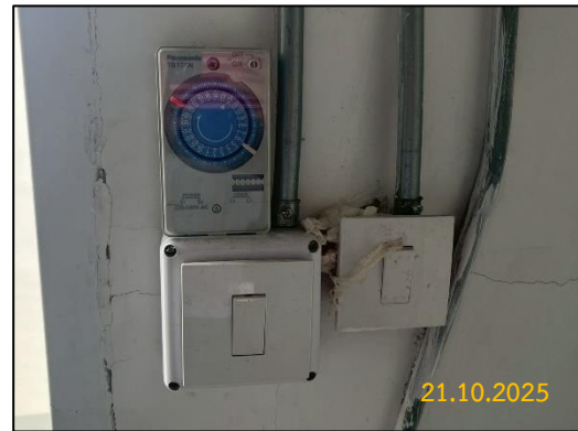
ภาพที่ 2-29 ระบบเปิด-ปิดไฟ ด้วยการตั้งเวลา
